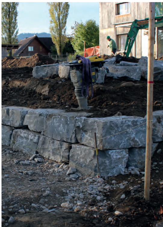
Hier noch im Bau: Der neue Demenzgarten des Pflegezentrums Schwarzenburg.
